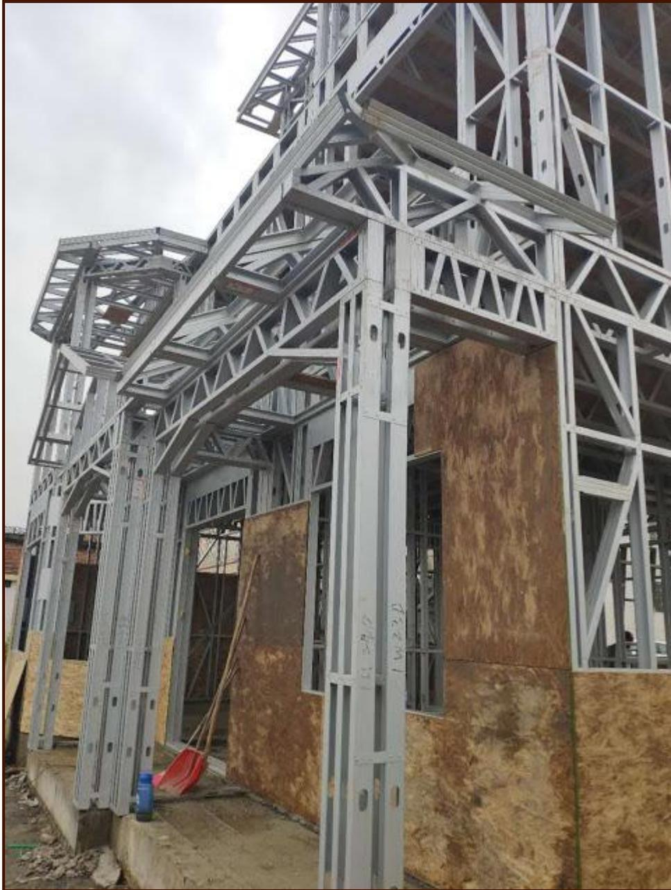
Bastidor de acero de perfil c de producción en masa hecho por máquina de conformado de metal.
